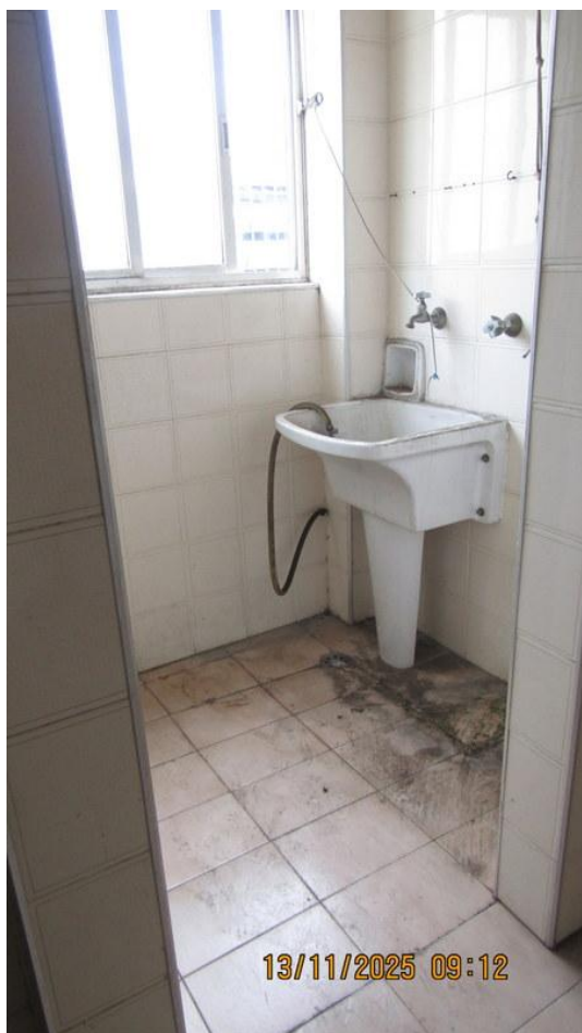
Foto 81 – Vista da área de serviço da unidade avlianda.
