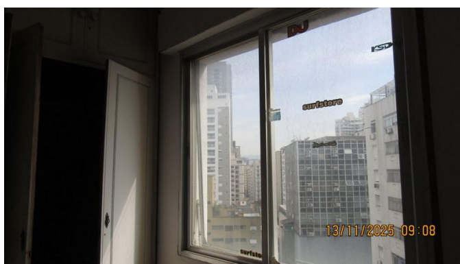
Foto 57 – Detalhes da janela do dormitório.
