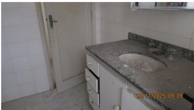
Foto 66 – Outra vista do banheiro do imóvel avaliando.
