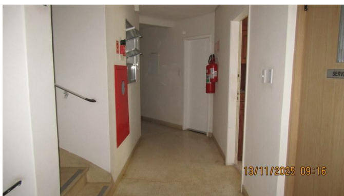
Foto 37 – Vista do hall de acesso ao imóvel avaliando.
