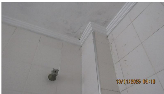
Foto 65 – Detalhes do teto do banheiro.
