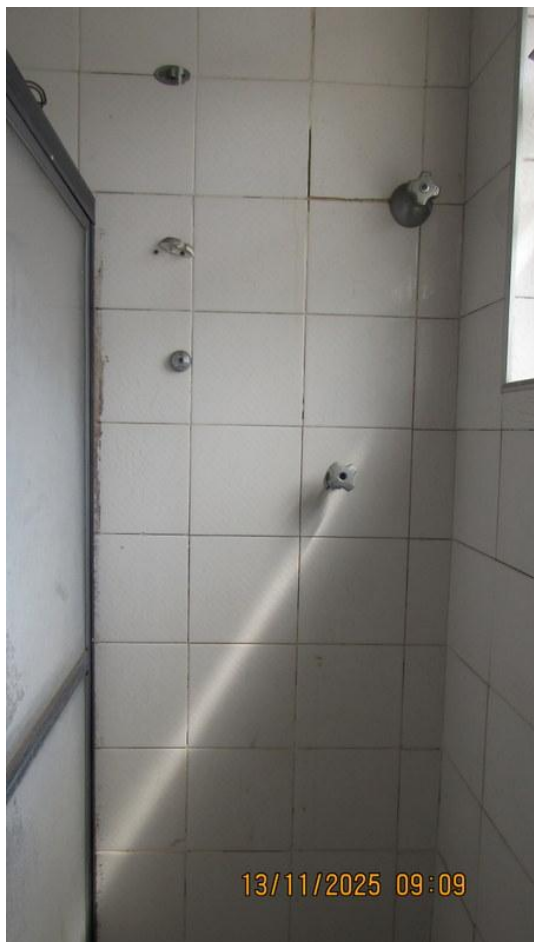
Foto 69 - Outra vista do banheiro do imóvel avaliando.
