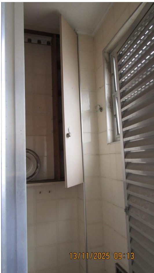
Foto 86 – Vista do wc do imóvel avaliando.
