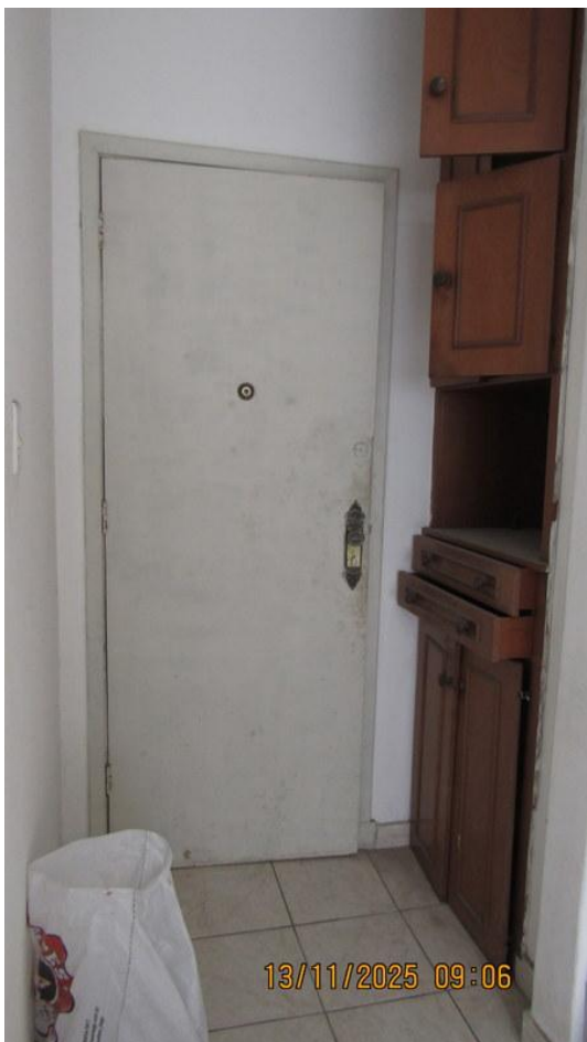
Foto 41 - Vista do hall de entrada do imóvel avaliando.
