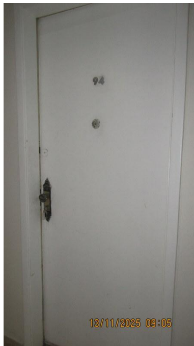
Foto 39 - Vista da porta social, com acesso a unidade nº 94 - tipo D.
