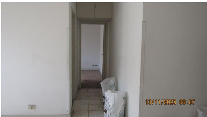
Foto 49 – Vista do hall de acesso ao dormitório e banheiro.
