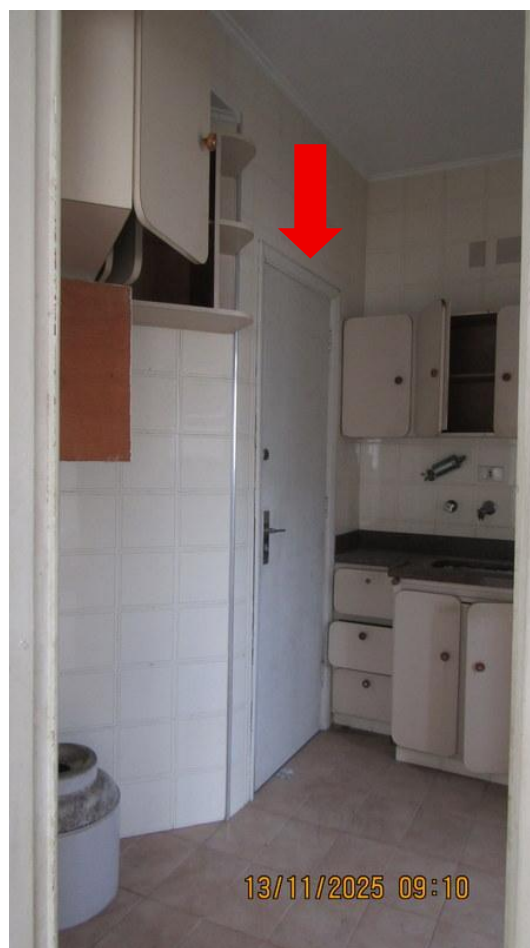
Foto 72 – Outra vista da cozinha do imóvel avaliando. A seta indica a outra porta de acesso ao imóvel avaliando.
