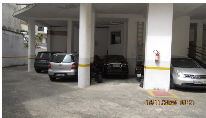
Foto 21 – Detalhes da garagem.
