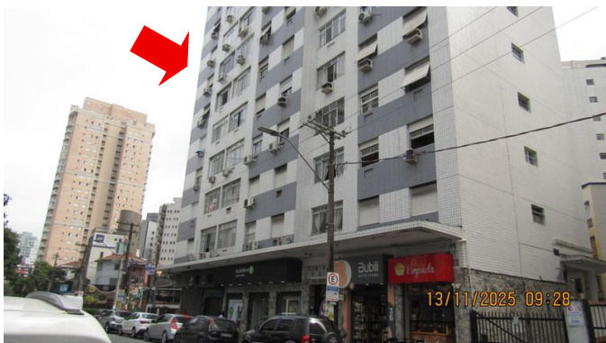
Foto 3 – Detalhes das fachadas do Condomínio do Edifício Di Franco.
