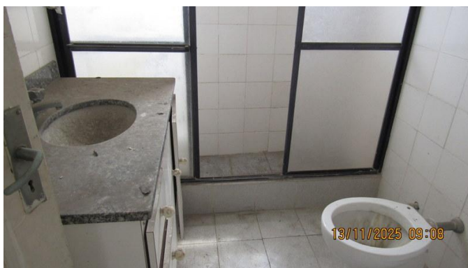
Foto 61 – Outra vista do banheiro do imóvel avaliando.
