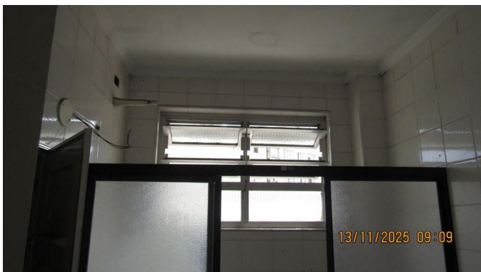
Foto 60 – Outra vista do banheiro do imóvel avaliando.
