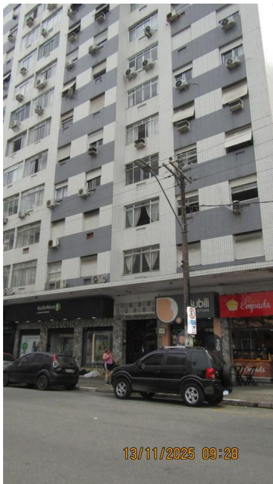
Foto 6 – Detalhes da fachada frontal do Condomínio do Edifício Di Franco.
