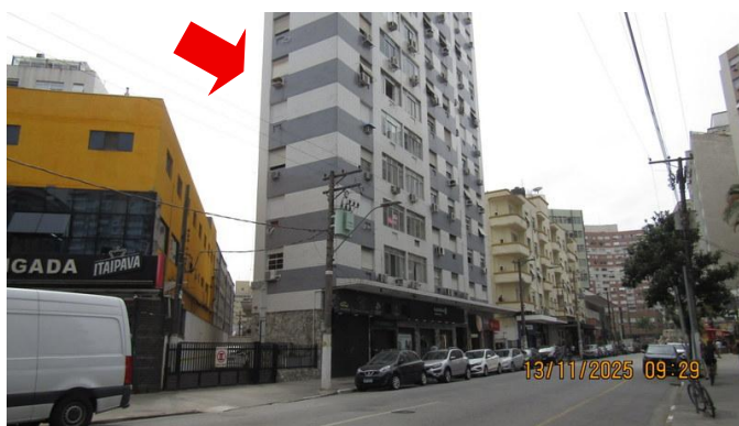
Foto 5 – Outra vista das fachadas do Condomínio do Edifício Di Franco.
