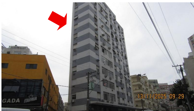
Foto 4 – Outra vista das fachadas do Condomínio do Edifício Di Franco.
