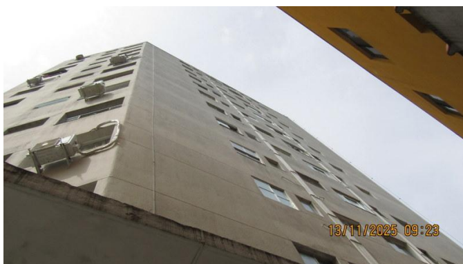
Foto 11 – Vista das fachadas de fundos do Condomínio do Edifício Di Franco.
