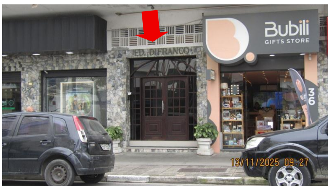
Foto 16 – Vista do acesso ao Condomínio do Edifício Di Franco.
