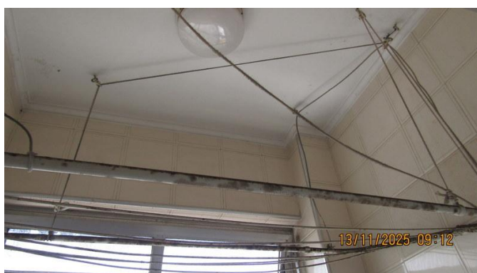
Foto 85 – Outra vista da área de serviço da unidade avalianda.
