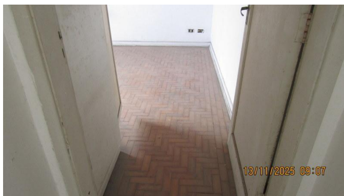
Foto 51 – Detalhes do acesso ao dormitório.
